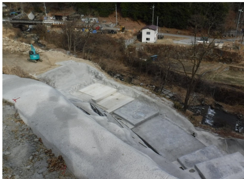
③擁壁工施工状況
