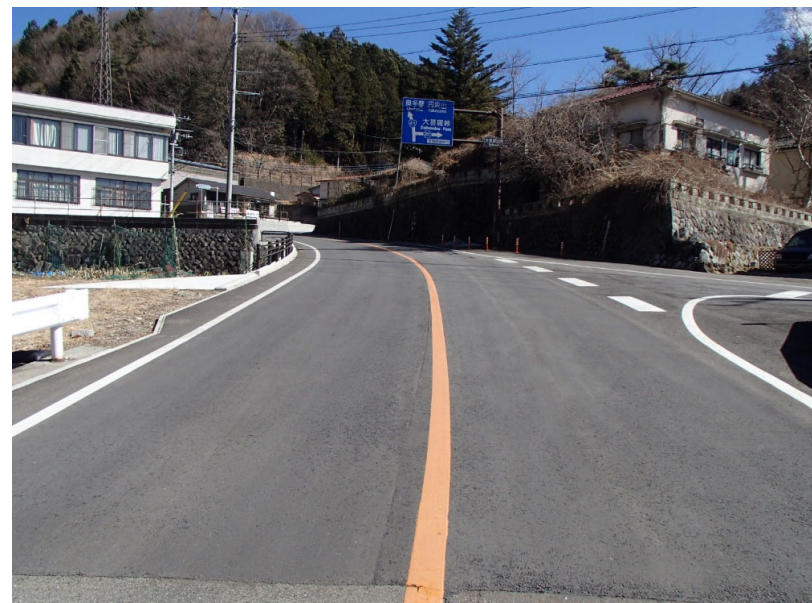
④改良済み区間の状況
