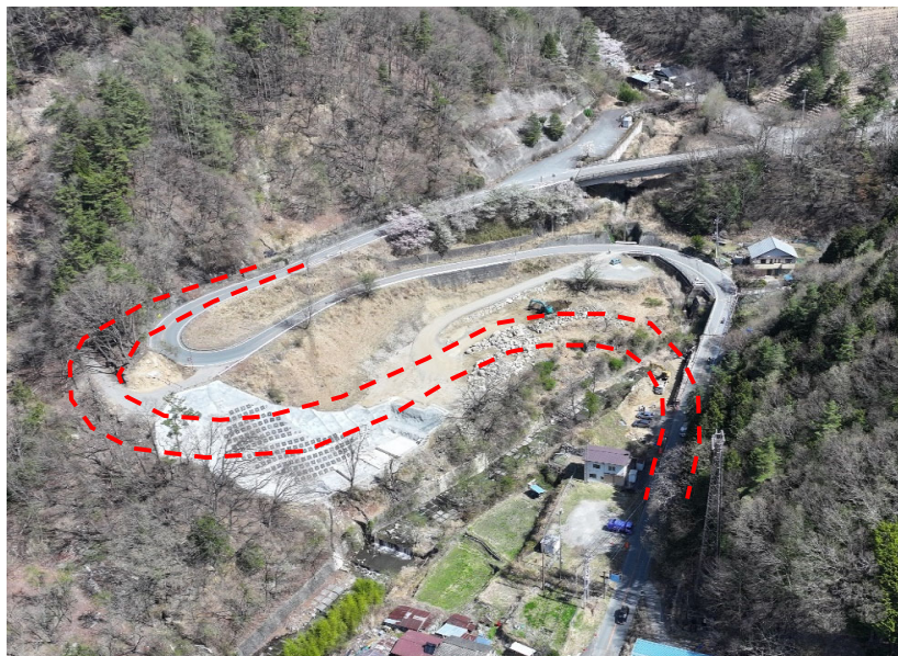
①工事着手状況全景
