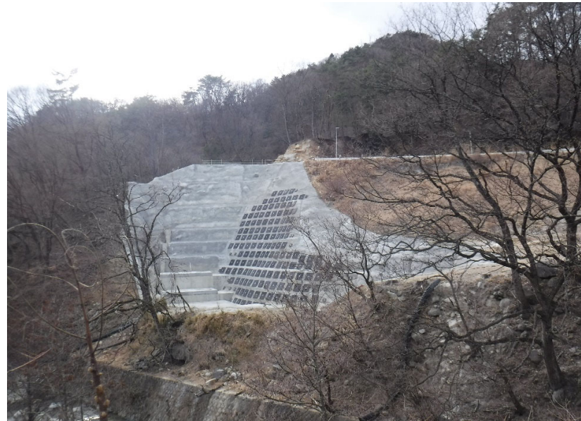
②擁壁工区間全景
