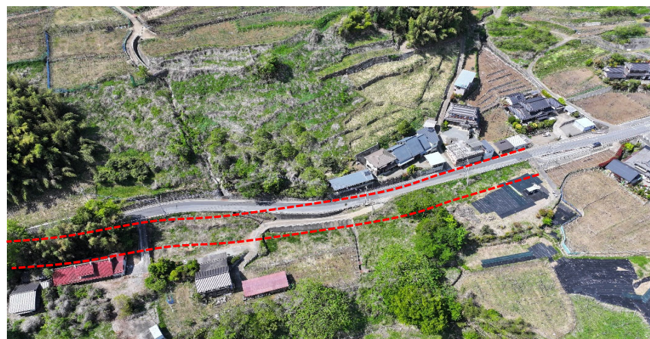
④事業進捗状況（用地買収済み箇所）
