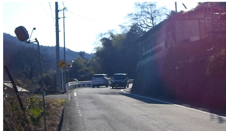
②幅員が狭く見通しが悪い（交通事故発生箇所）
