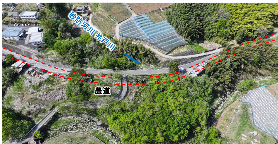
③既設渡河構造箇所と農道取付部
