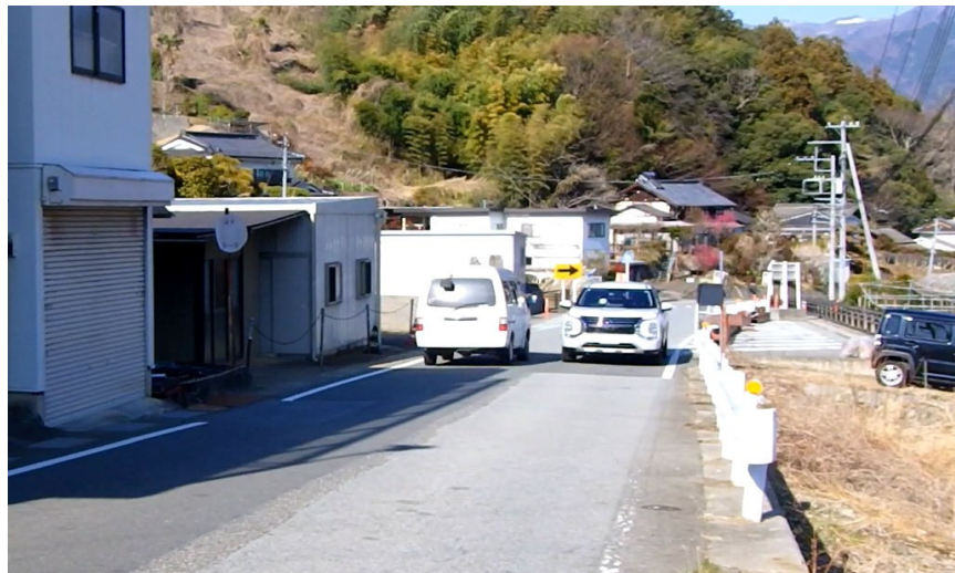
①幅員が狭く、すれ違い時に危険な状況
