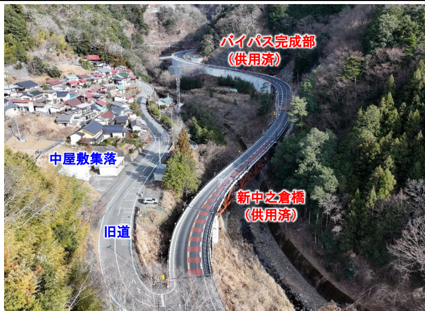
⑤ 進捗状況（新中之倉橋付近） ～中之倉集落とバイパス区間～（完成）
