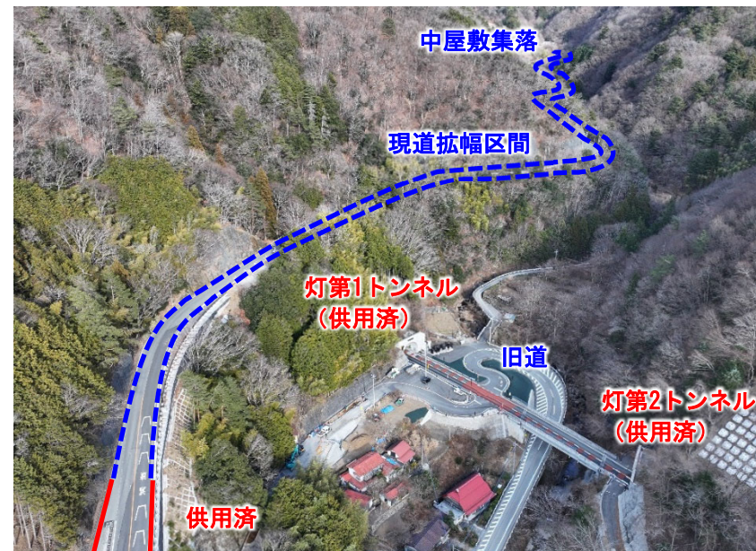
⑧ 進捗状況（供用区間～未改良区間）
