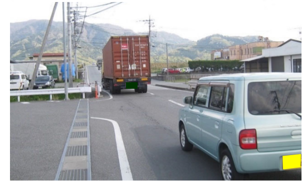
①道路状況(路肩部狭小)
