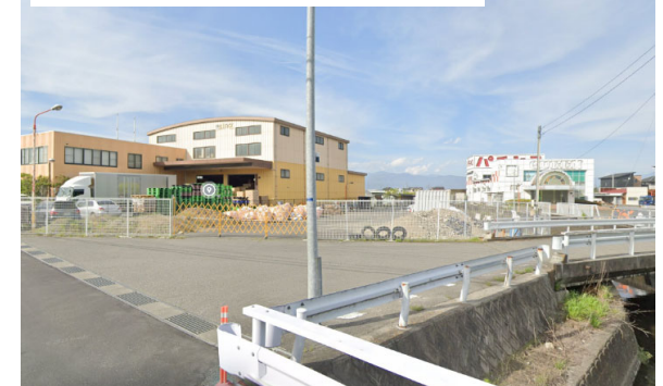
②施工時用地(上流右岸)を望む
