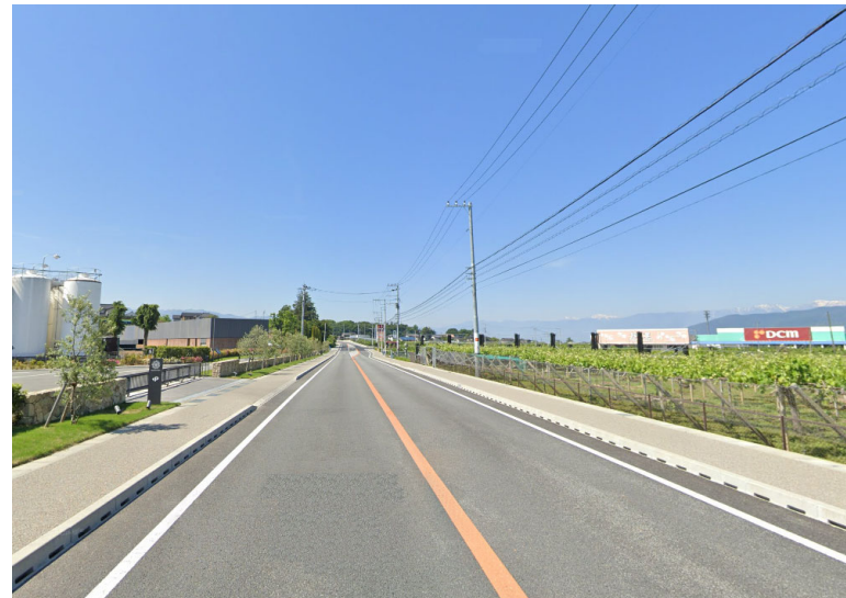
④改良済み区間の状況
