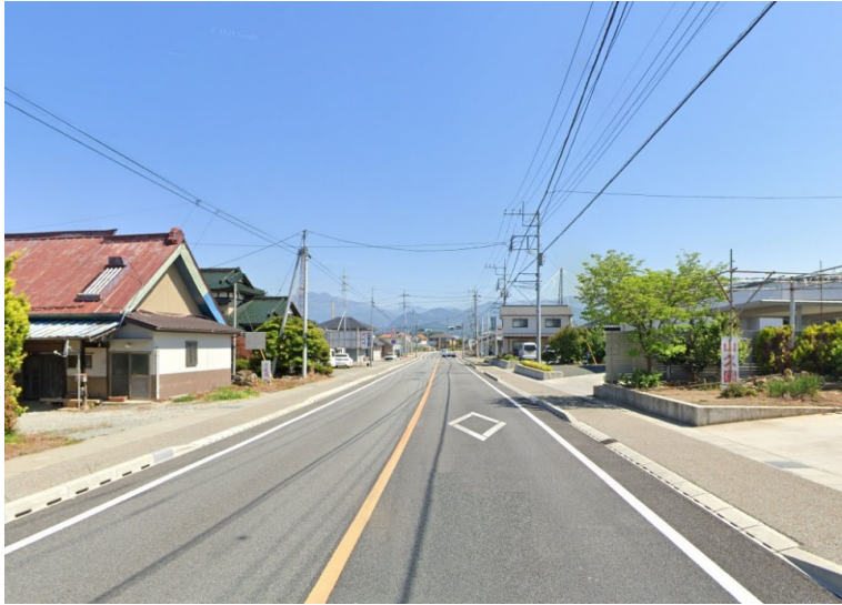
①改良済み区間の状況
