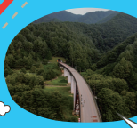
雁坂トンネル入口
