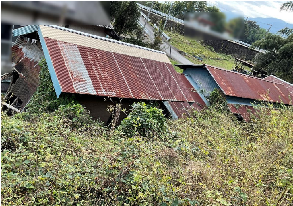
⑦建物を北側から撮影
