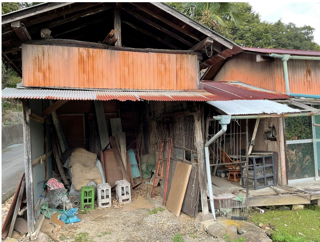
⑤倉庫を南東側から撮影
