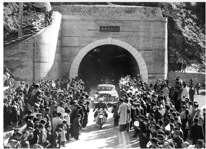
新笹子トンネル開通
