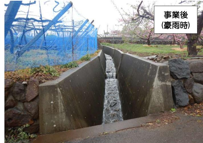
水路の整備により台風や豪雨時においても雨水が適正に排水されるようになり、溢水被害が解消され、果樹の品質が向上するとともに、維持管理の労力が軽減された。
