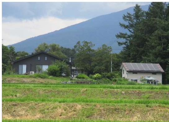
⑤ ため池下流には人家があり、大規模地震の際には甚大な被害のおそれがあるため、早急に対策を講じる必要がある。
