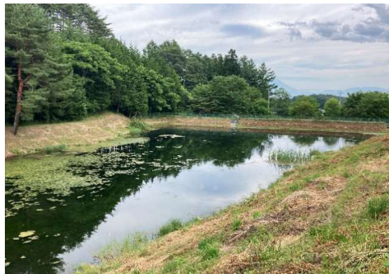
④ 米山ため池 全景 貯水量 15,000m 3 、堤高 H=5.6m
