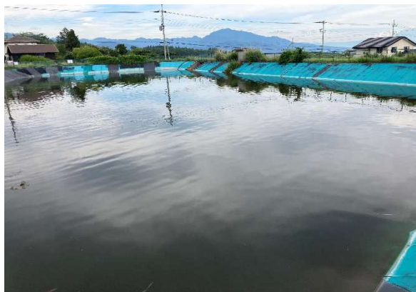
① 小岩清水ため池 全景 貯水量 5,000m 3 、堤高 H=4.4m
