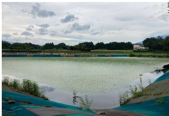
① 上黒澤新ため池 全景 貯水量 11,800m 3 、堤高 H=5.7m
