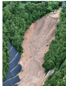
▲ 廃棄された土砂の崩落により軽傷者1名、 県道通行止め
