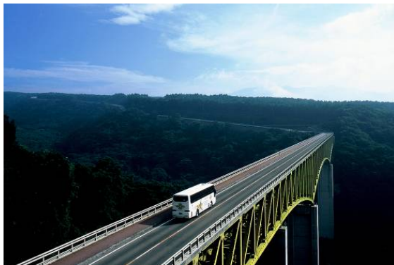
ハケ岳高原大橋 県道・北杜ハケ岳公園線 照明を高欄埋め込みにし、道路からの眺望景観を確保するとともに、周辺からの視対象としても景観に配慮した。
