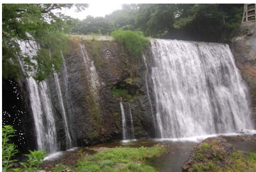
勝沼堰堤（日川） 甲州市勝沼町・大和町
