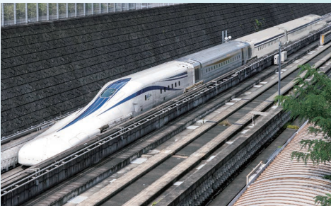
山梨リニア線で走行試験中のL0系改良型試験車(画像提供:JR東海)
