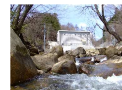
琴川第三電所
