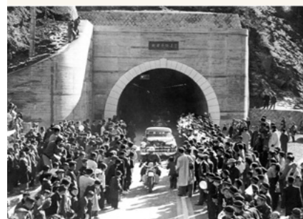
新笹子トンネル開通
