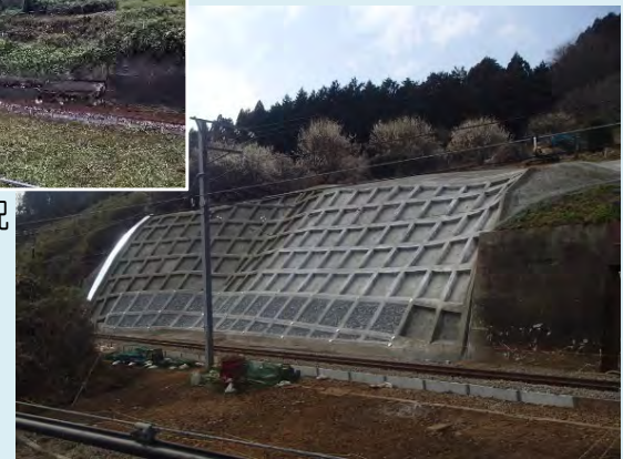
③吹付格子砕工・排水設備整備
