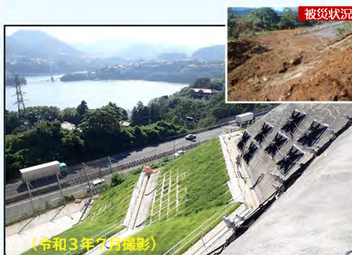
（令和3年7月撮影） 写真：中央自動車道 与瀬地区の復旧作業完了状況
