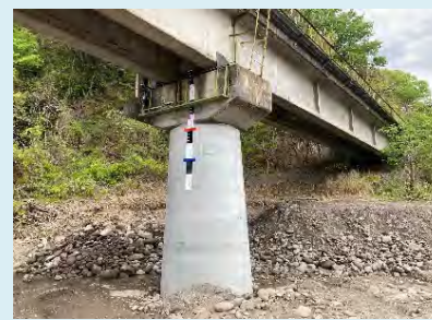
③塩崎・韮崎間 (2023年5月完了)
