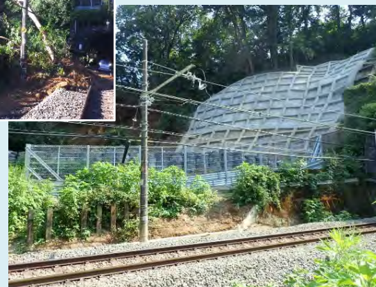
②吹付格子砕工・土砂止め柵設置
