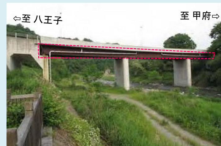
つるかわ ③ 鶴川橋 【橋梁補修】構造物補修等
