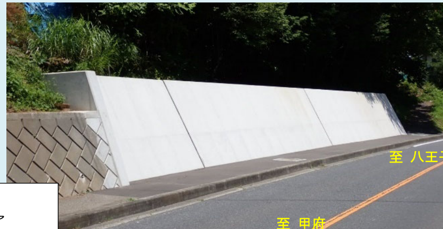
はちおうじしみなみあさかわまち ① 八王子市南浅川町 重力式擁壁による本復旧完了
