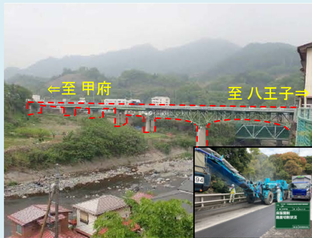
おおつき ① 大月橋 【橋梁補修】構造物補修、舗装補修等
