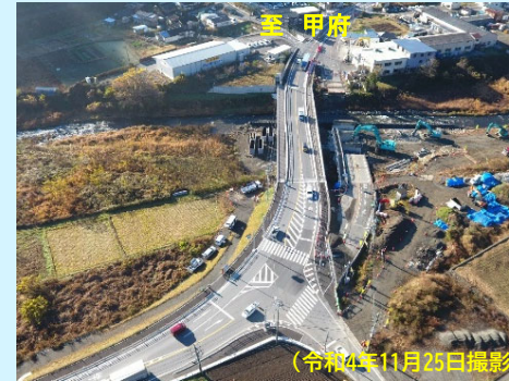
国道20号法雲寺橋新設橋の供用後
