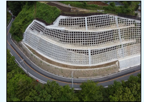
国道413号道路災害防除工事の施工後
