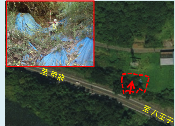
③ 山梨県上野原市松留地先 【防災対策】吹付法砕工等
