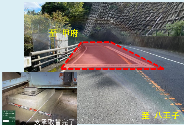
② だいいちさんどう 【橋梁補修】主桁補修、支承補修等
