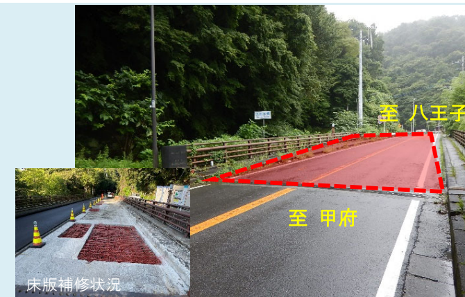
③ おおたるみ 【橋梁補修】主桁補修、床版補修等
