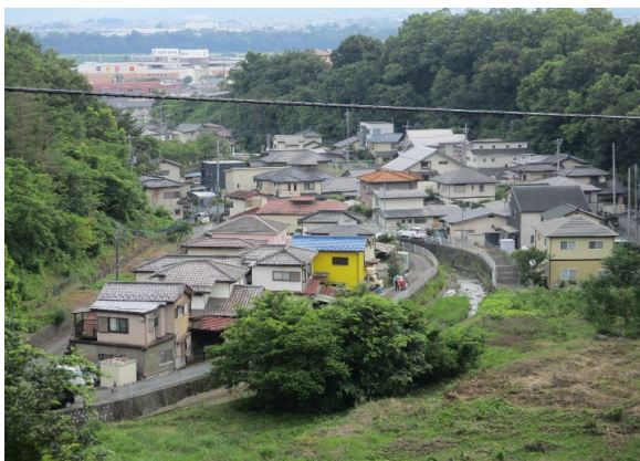
② ため池下流には人家があり、大規模地震の際には甚大な被害のおそれがあるため、早急に対策を講じる必要がある。
