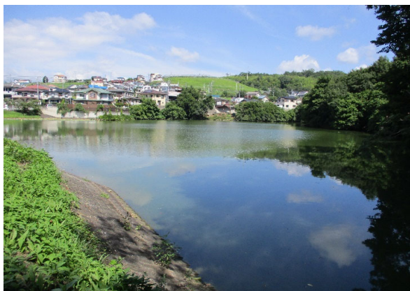
① 新田ため池 全景 貯水量 42,000m 3 、堤高 H=9.6m
