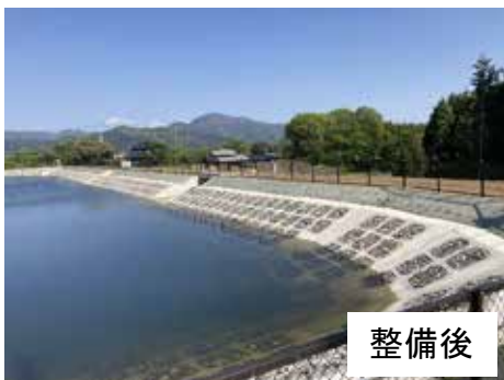
防災・減災対策（農業用ため池）
