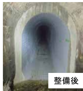
農業用施設の長寿命化 （水路トンネル）
