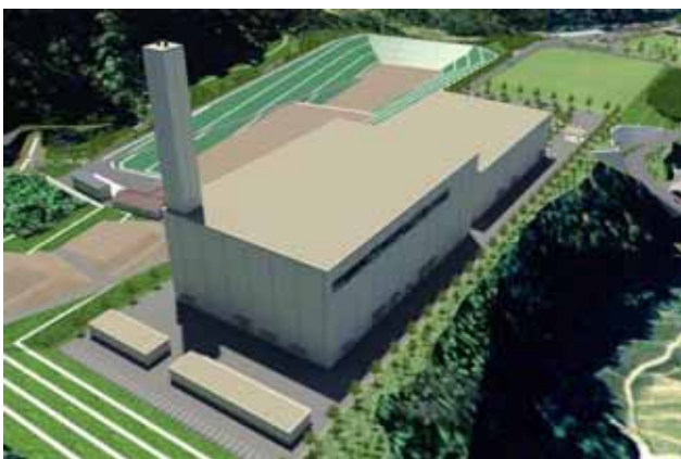
図 5-2-1(5) ごみ処理施設イメージ図 (煙突位置：南東端、煙突高さ：100m)
