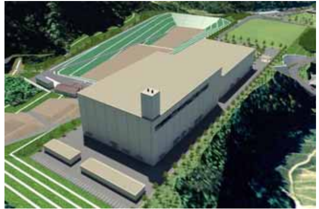
図 5-2-1(2) ごみ処理施設イメージ図 (煙突位置：北東端、煙突高さ：59m)
