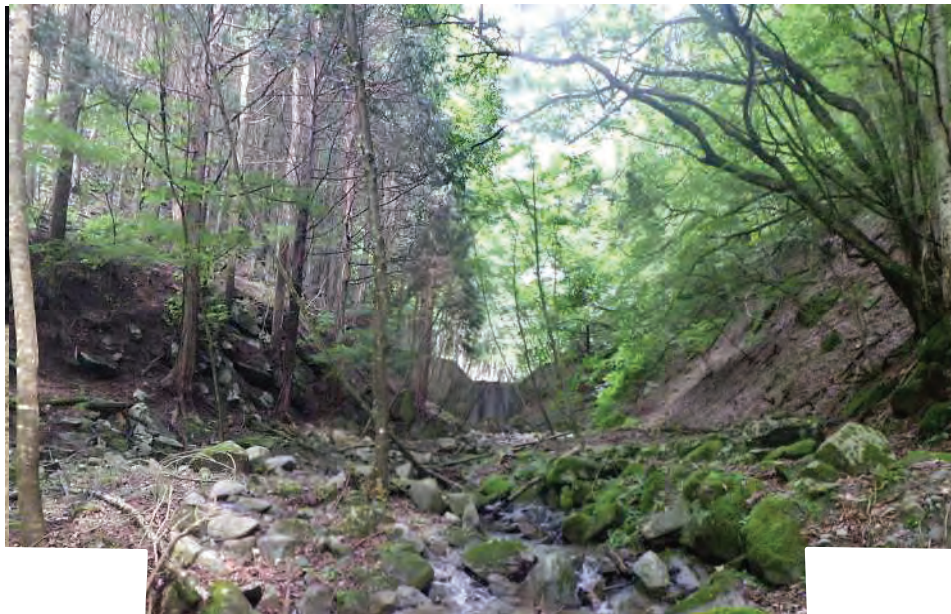
⑥ 橋梁計画箇所の状況
