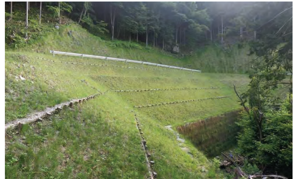
⑦ 補強土壁工による盛土箇所
