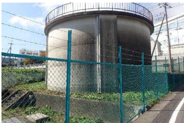
写真 8. 1. 8-9 富士吉田市 白糸配水場 配水池
