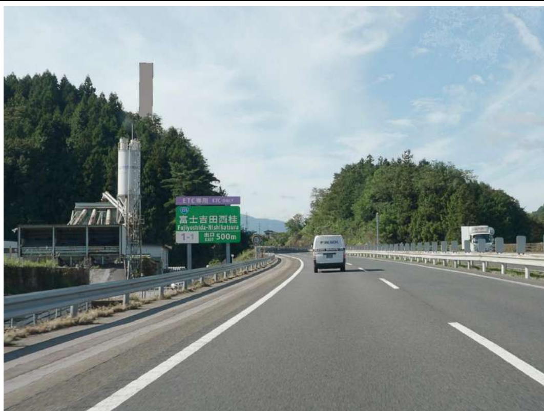
No.5-② (煙突高さ 100m)
