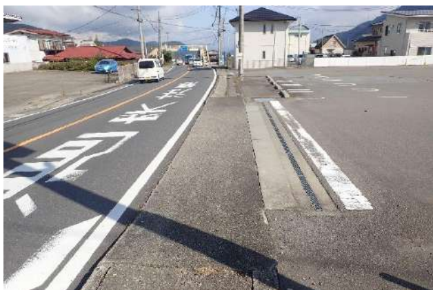
写真 8. 1. 8-11 一般国道 139 号 舗装
