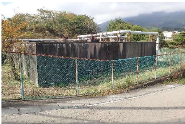
写真 8.1.8-13 西桂町 高圧配水池 コンクリート構造物・配管・舗装
