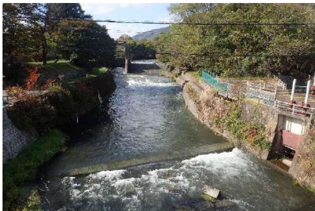
写真 8. 1. 8-7 桂川明見取水口堰堤付近 水路
