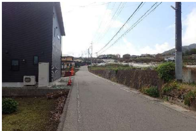
写真 8.1.8-14 県道 718 号 舗装・建物
