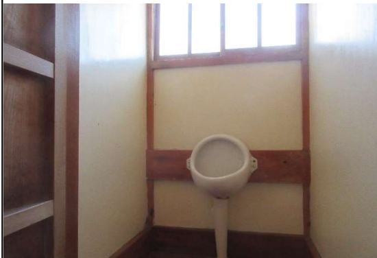
トイレ(小便器)
