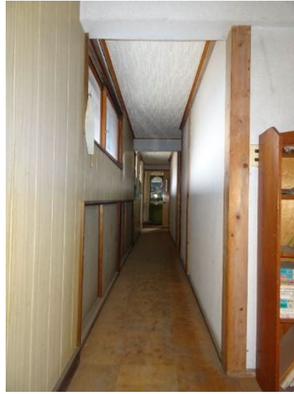
2階廊下(左下は下屋小屋裏収納)
