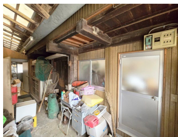
蔵外観(土間より見る)
