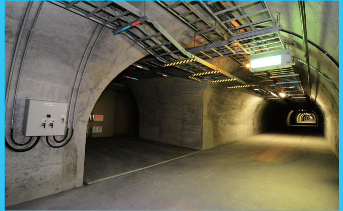
普段入ることが出来ない雁坂トンネルの避難坑
