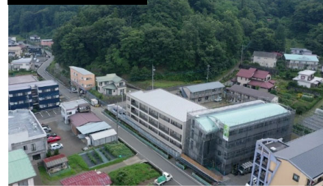
③斜面状況(全景)
