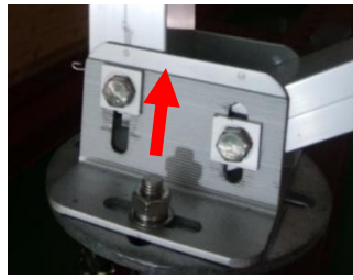
図 D8 柱脚接合部の滑り
