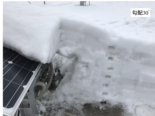
写真 B1 軒下積雪の状況（札幌市を例として）
