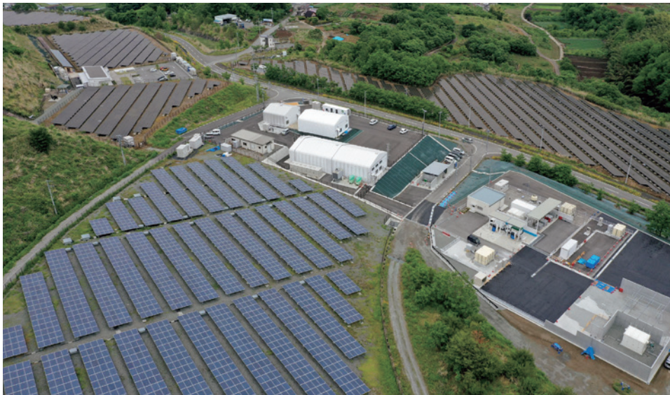
米倉山電力貯蔵技術研究サイト全景
