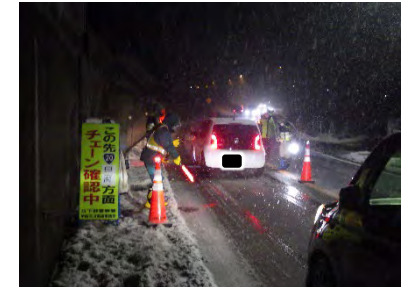
国道20号大月市大月地先 （タイヤチェック実施状況）
