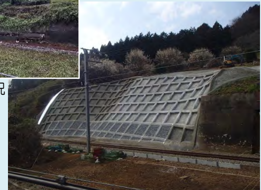
③吹付格子砕工・排水設備整備
