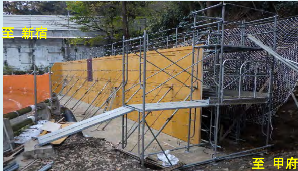
① はちおうしのみなみあさかわまち 八王子市南浅川町 斜面崩落防止対策工（重力式擁壁＋落石防護柵工）
