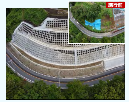
写真：国道413号道路災害防除工事の施工後
