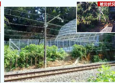
写真：JR中央本線の復旧作業完了状況
