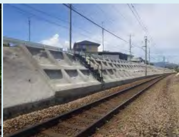
②塩崎・萁崎間 (2022年10月完了)
