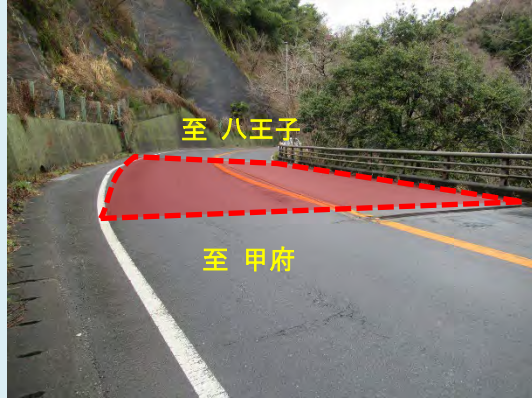
① だいにさんどう 第2栈道橋 【橋梁補修】主桁補修、支承補修等
