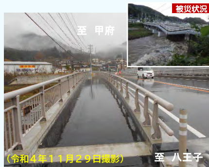
写真：国道20号 法雲寺橋の完成後
