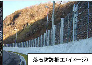
① はちおうしのみなみあさかわまち 八王子市南浅川町 斜面崩落防止対策工（重力式擁壁＋落石防護柵工）
