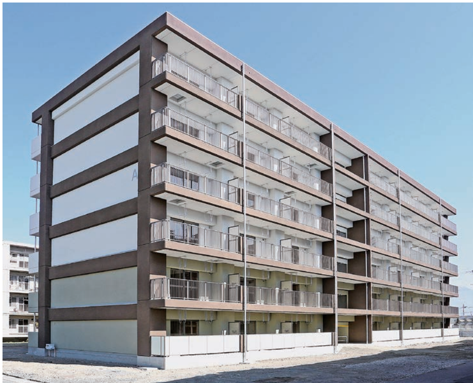
県営住宅 玉川団地（建替事業）
