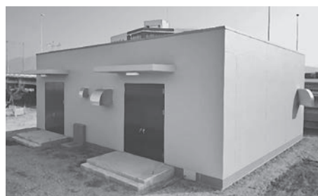
国道411号（仮称）砂田排水機場建屋
