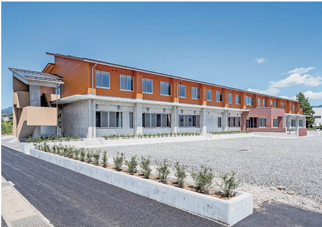
総合農業技術センター 外観
