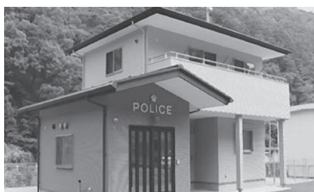
南アルプス警察署芦安駐在所
