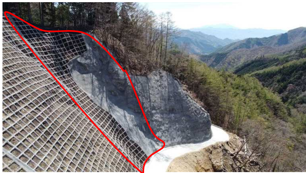
対策完了状況 (R2崩落部)
