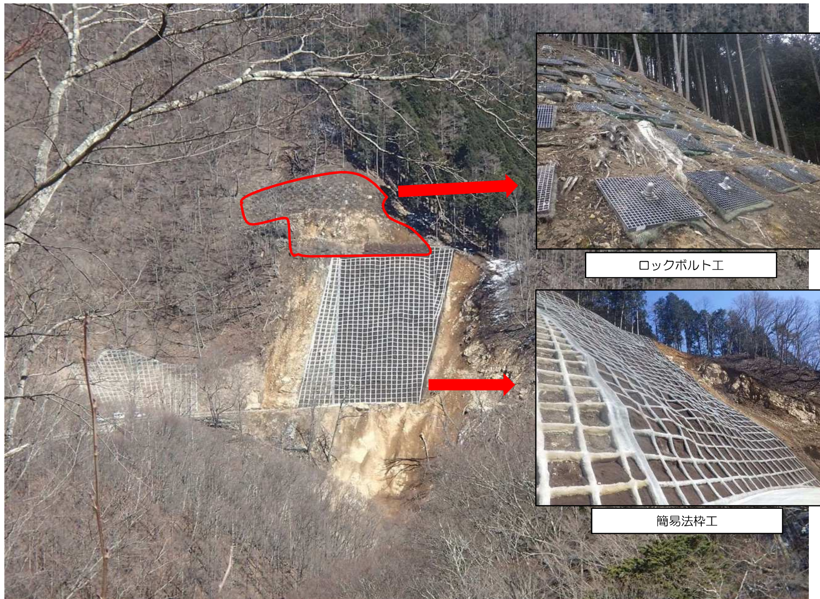
③ 対策完了状況(H28崩落部)
