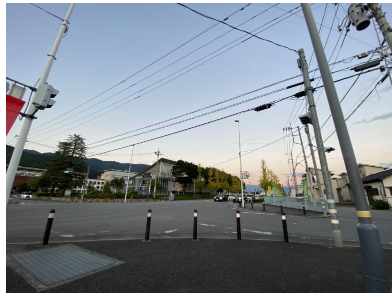
【写真④】道路上に張り巡らされた電線類
