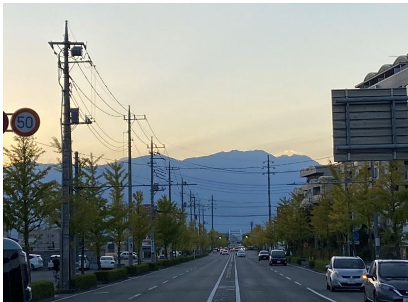
【写真③】災害時に倒壊する恐れのある電柱
