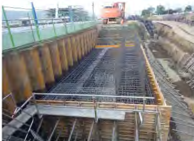
渋川右岸橋台 令和4年4月末の状況
