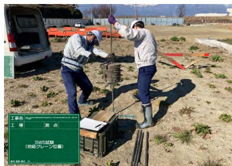
クレーン設置位置の地耐力確認
