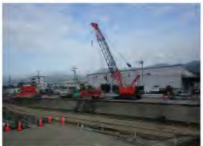
渋川左岸場所打杭 令和4年4月末の状況
