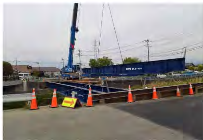
仮橋撤去状況
