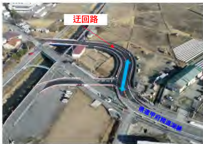
迂回路撤去前（R3.2.5の写真）
