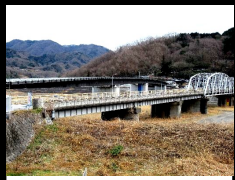
富士橋(建設中)
