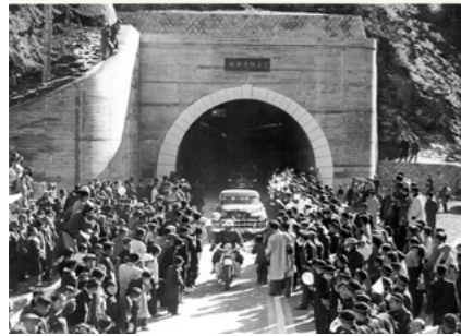
新笹子トンネル開通
