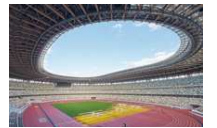
国立競技場スタンド 観客席を覆う大屋根に県産 FSC 認証材（カラマツ）を使用（提供：独立行政法人日本スポーツ振興センター）
