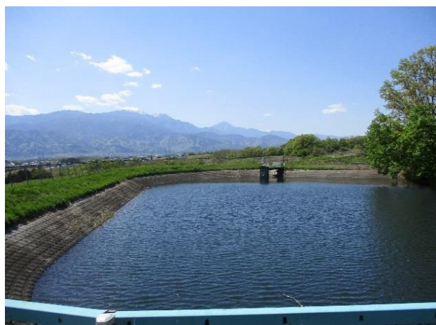
① 大久保ため池 全景 貯水量 5,000m 3 、堤高 H=6.7m
