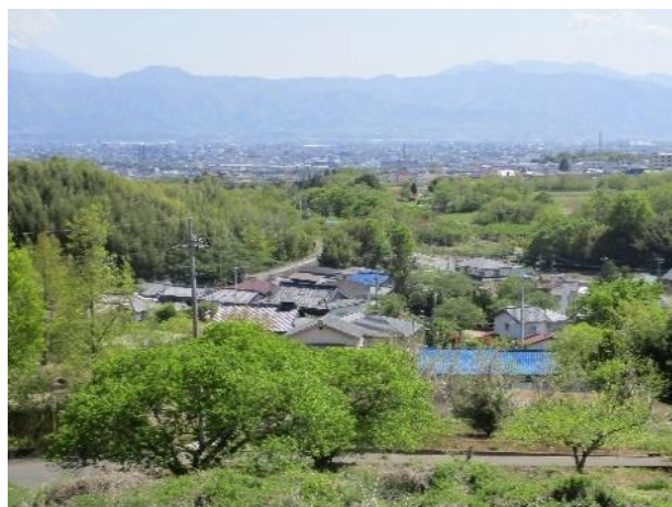
② ため池直下には人家があり、ため池が決壊した際には甚大な被害のおそれがあるため、早急に対策を講じる必要がある。
