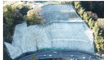
法面对策・国道20号
