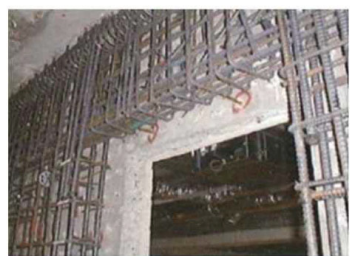
躯体補強（RC断面増厚工法）
