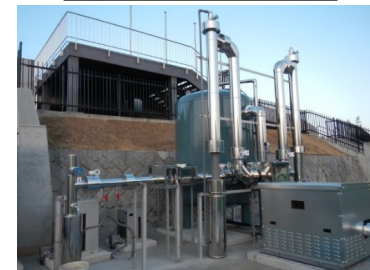
防災用井戸設置
