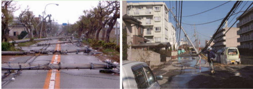
災害時の救援活動を妨げる電柱（国土交通省HPより）
