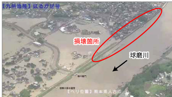
日本三大急流 球磨川（熊本県）の氾濫 人吉市付近の被災状況（堤防損壊）
