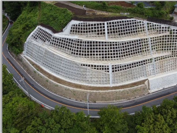
国道413号 [道志バイパス]
