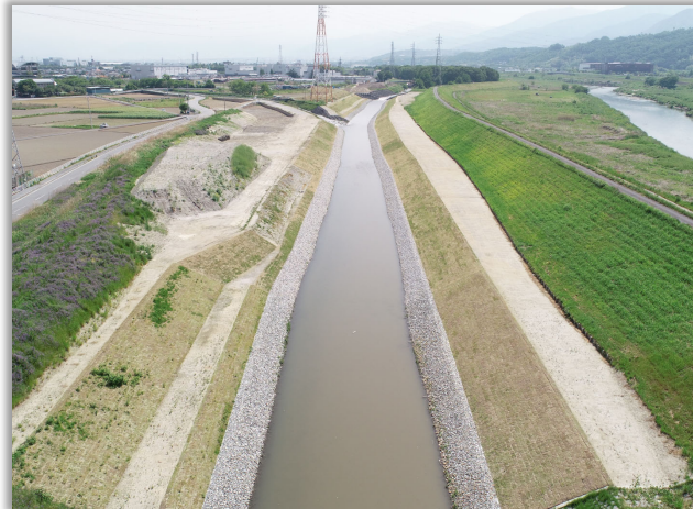
鎌田川 [河川改修]
