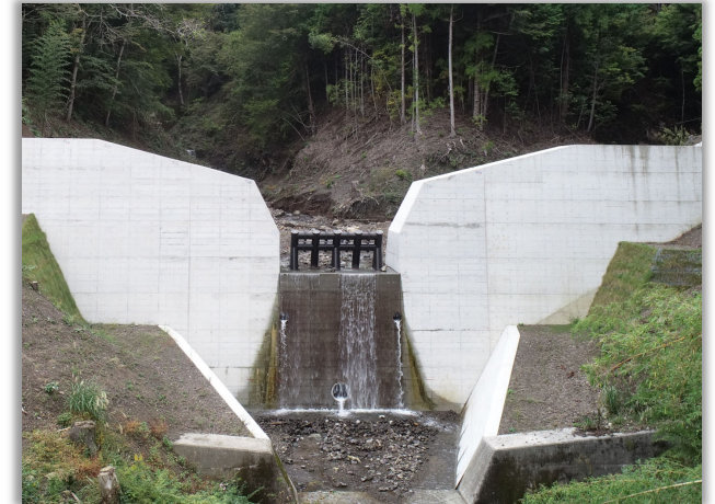
畔沢川 [砂防堰堤]
