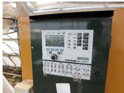
図3 使用した環境制御盤 (NEPON社 MC-6001)
